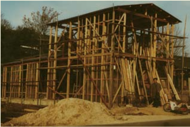
建設中の川名山会堂
